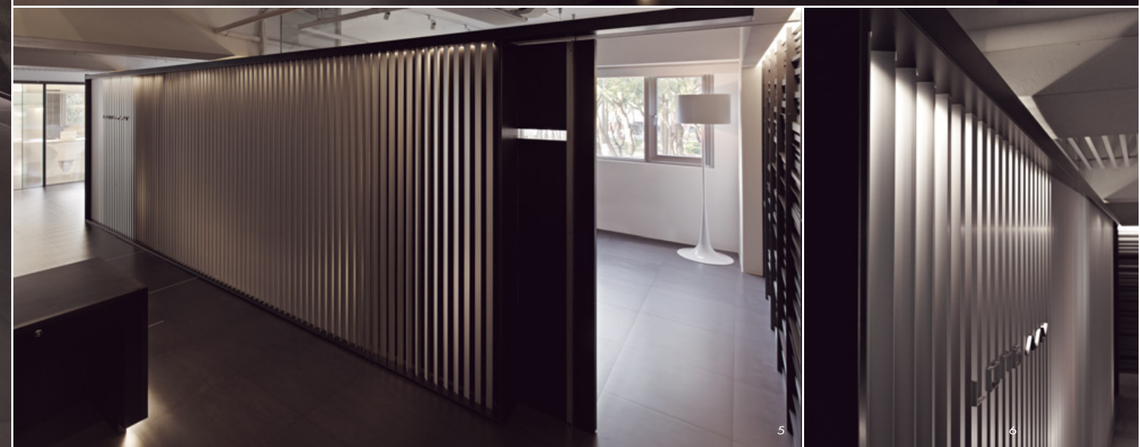
3. 垂直向與水平向的視覺線條脈絡，加上陽極處理與生鏽鐵件的材質對比，入口即充滿對話與張力。4.5. 不同視覺角度欣賞入口主牆，透過光線打在L型鋁料上不同的陰影面積，形成有律動感的拋物曲線。6. 每5度轉折的變化，隱約產生一條曲線。7. L型鋁料的轉向，使垂直間距產生疏密的錯覺，像是正在被翻轉的律動。
